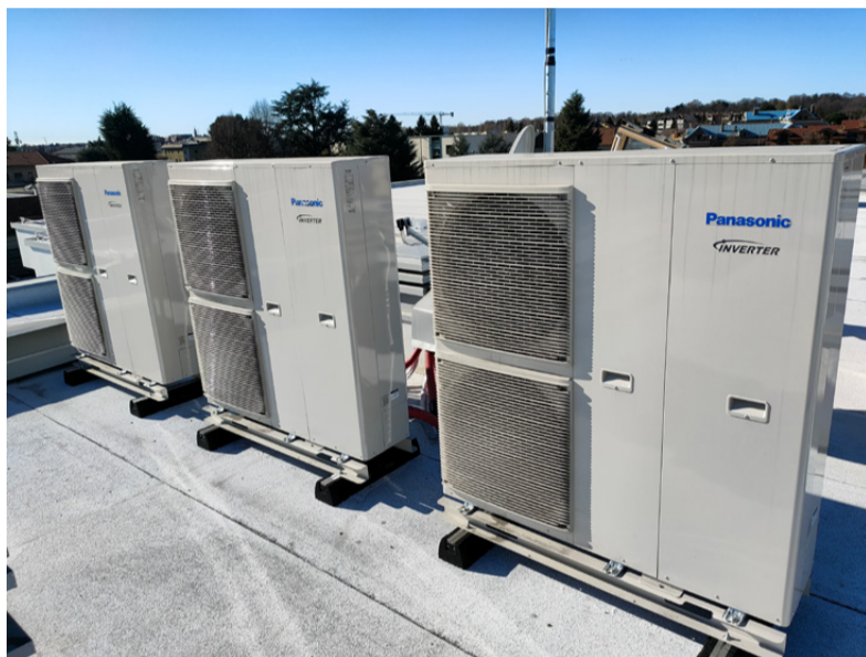
Sopra I MODULI interni. L'impianto centralizzato è costituito da tre pompe di calore Aquarea T-CAP Super Quiet collegate in cascata
