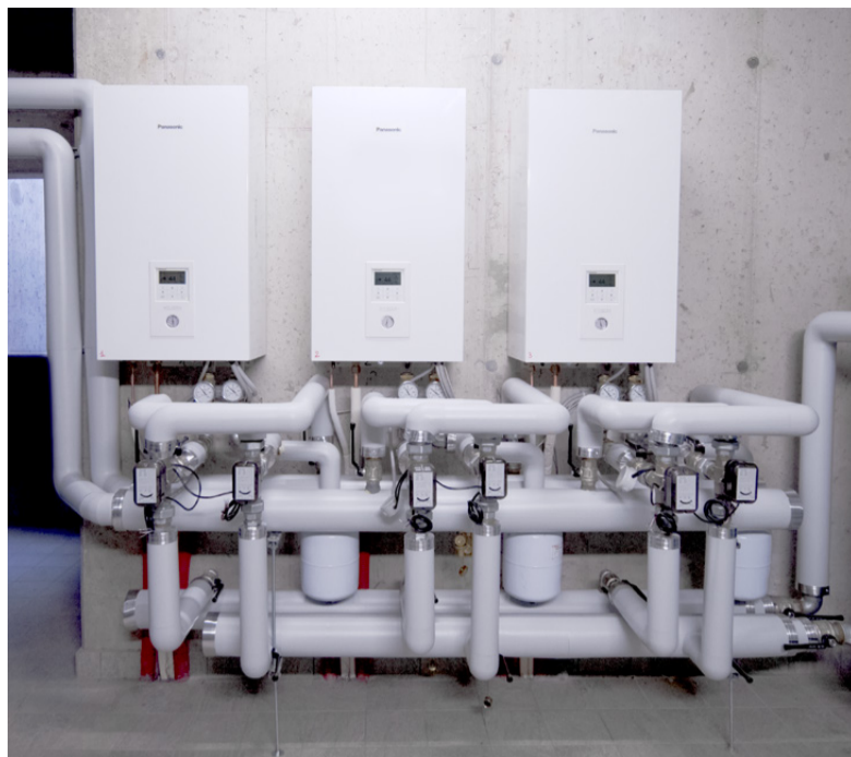
Sopra I MODULI interni. L'impianto centralizzato è costituito da tre pompe di calore Aquarea T-CAP Super Quiet collegate in cascata
