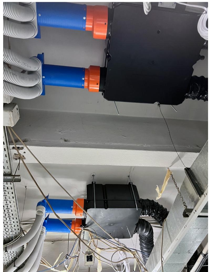
REALIZZAZIONE di un impianto VMC
