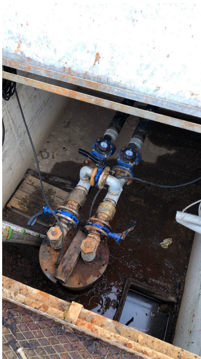
REALIZZAZIONE di un pozzo geotermico
